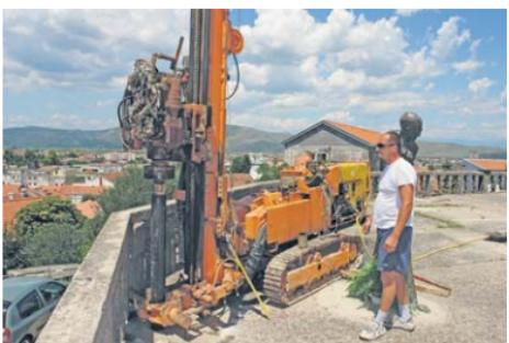
Tvrta Geosonda iz Splita započela je s radovima na saniranju potpornog zida dvorišta oko crkve Sv. Ilije. U prvoj fazi izbušit će se dvadeset rupa za armiranobetonske pilote nakon čega slijedi uklanjanje betonske ploče dvorišta i stare betonske ograde. Namjesto betona dvorište će se popločati kamenom, a oko njega će se izgraditi nova ograda od punog kamena.
